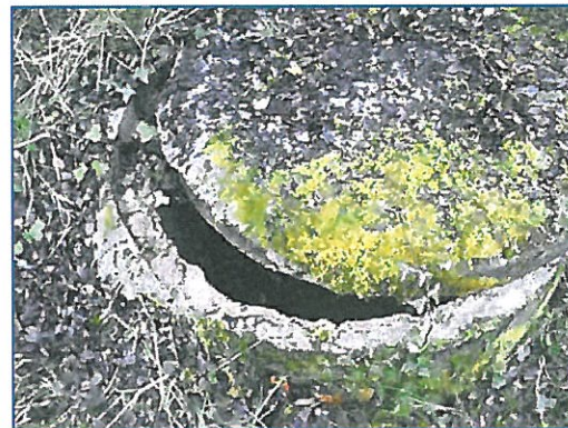
Puits légèrement ouvert
