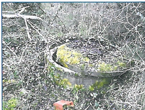
Puits légèrement ouvert
